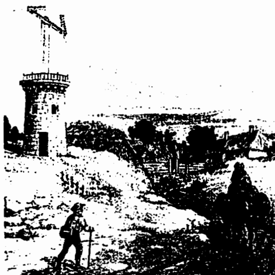
Abb. 1: Ansicht einer optischen Telegraphenstation [2]
