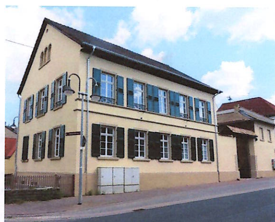
sanierte historische Holzklappläden
