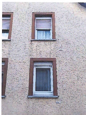
nachträglich eingebaute Aufsatzrollläden mit ansprechend gestalteten Rollladenkästen
