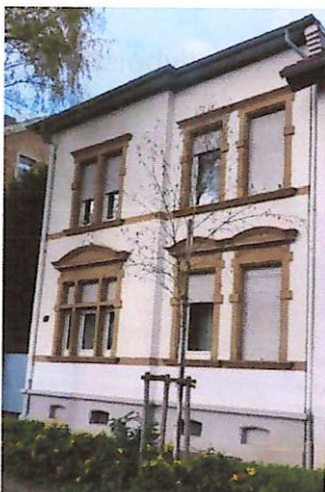
nachträglich eingebaute Aufsatzrollläden mit von außen nicht sichtbaren Rollladenkästen
